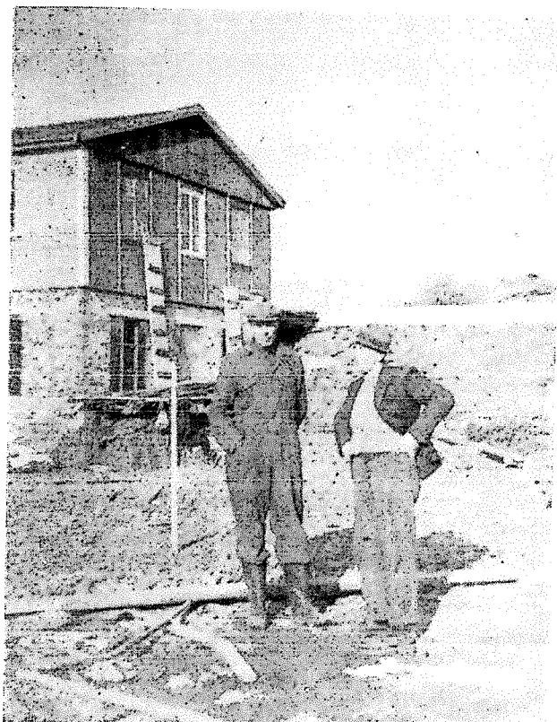
Onar Onarheim og Ottesen. — Bak dem er maskinverkstedet kommet opp
