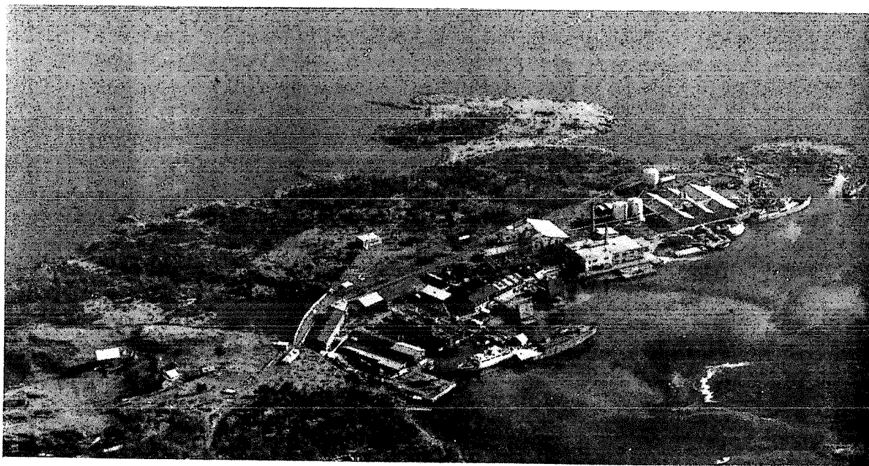
A/S Stords anleggsområde sett fra luften.
